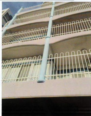
2001年: 18年前施工の沖縄海岸前マンション外壁
