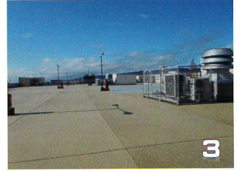
エポキシモルタル充填
