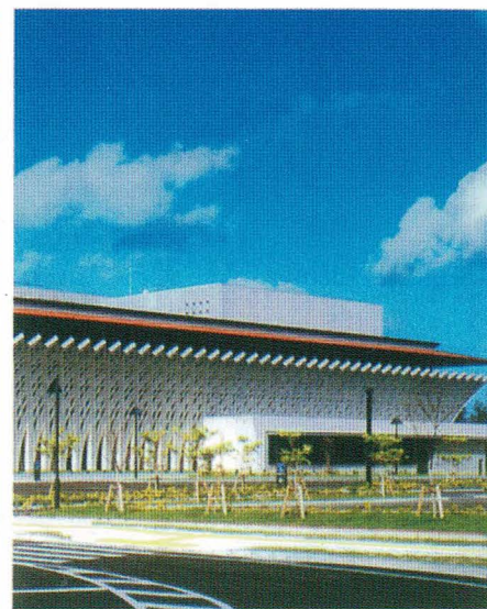
H17. 国立劇場おきなわ(打放しコンクリート・PC) 第5回国土交通省、宮繕技術コンクール優秀賞
